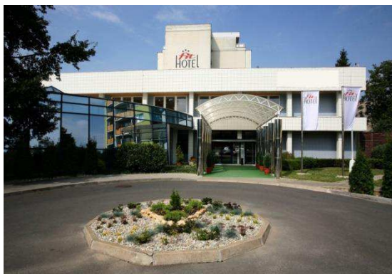
Obrázek 10: Hotel Fit (Zdroj: autor, web hotel Fit)
